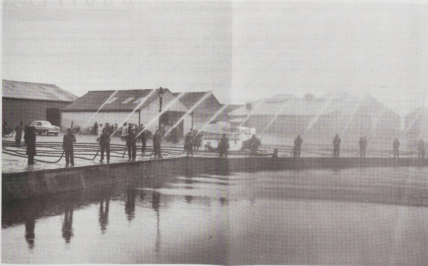
Deze foto heeft geen betrekking op de Ramp van 1953, maar Brandweerlieden staan altijd klaar om mensen in nood te helpen! Tijdens de Rampdagen hebben zij bijna geen oog dicht gedaan. Hier een oefening op de Kaai van Sommeldijk. (foto D. H.)
